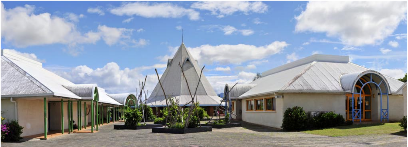
Le lycée agricole de Pouembout - Nouvelle-Calédonie
