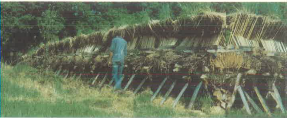
«Le mur, construire ensemble l'éloignement», Date : février-mars 1988, Situation : La petite petite Guittière près de St Philbert de Grand Lieu; Matériaux : piquets d'ardoise, bottes de paille, bois de chauffage, fagots de sarment de vigne, graminées, baguettes de bois, pierres, terre, prairie permanente et verger abandonné.
